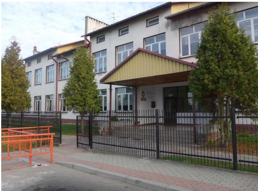
Zdjęcie 35: Budynek Szkoły Podstawowej w Wilkowej Fot. GRACZKOWSKI DOTACJE Sp. z o.o., październik 2015r.
