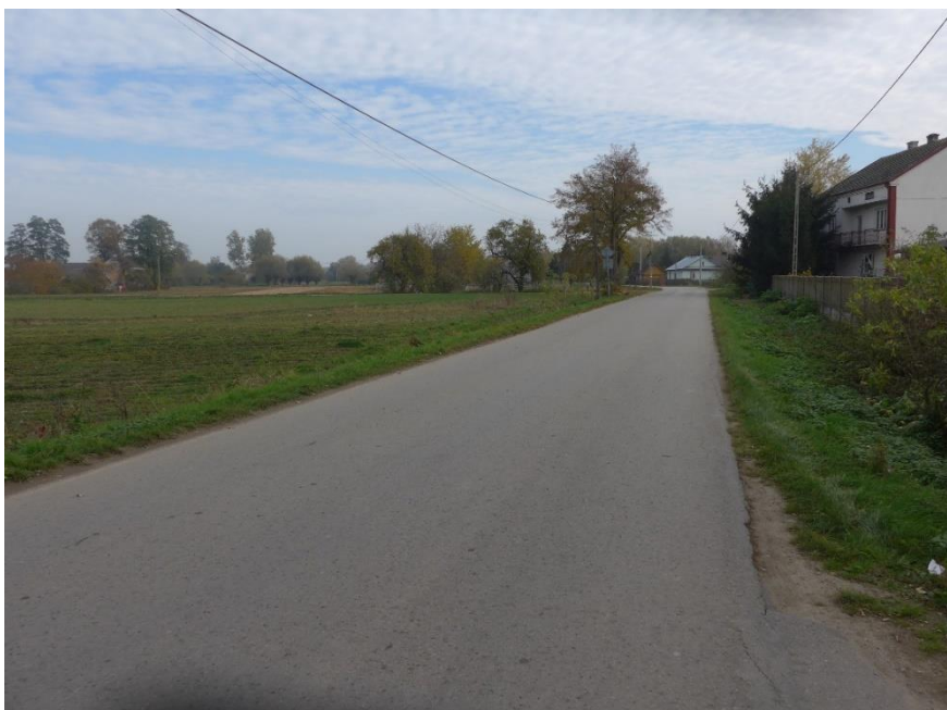
Zdjęcie 14: Droga w sołectwie Budziska Fot. GRACZKOWSKI DOTACJE Sp. z o.o., październik 2015r.
