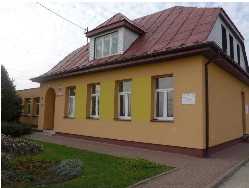
Zdjęcie 17: Budynek Szkoły Podstawowej w Gacach Słupieckich Fot. GRACZKOWSKI DOTACJE Sp. z o.o., październik 2015r.
