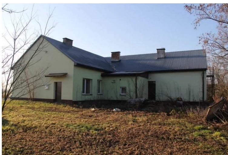
Zdjęcie 11 Obiekt kultury w miejscowości Przeczów – stan obecny. Fot. Urząd Gminy Łubnice
