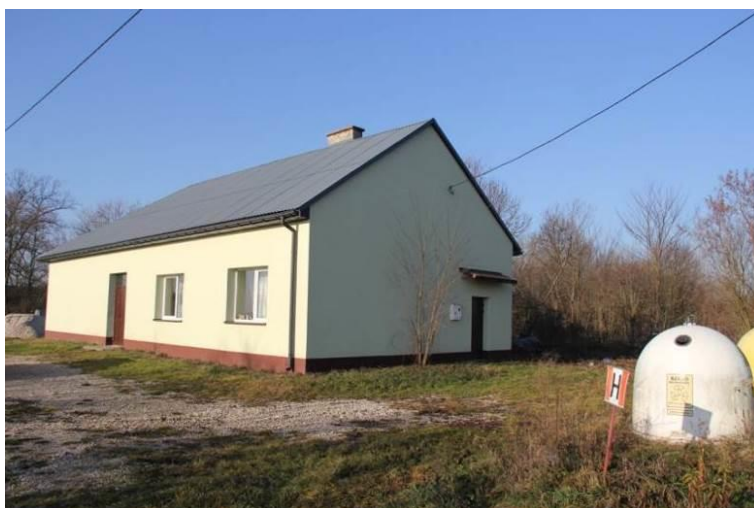
Zdjęcie 12 Obiekt kultury w miejscowości Przeczów – stan obecny. Fot. Urząd Gminy Łubnice
