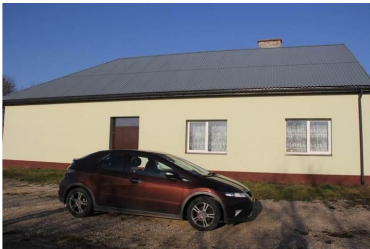
Zdjęcie 10 Obiekt kultury w miejscowości Przeczów – stan obecny. Fot. Urząd Gminy Łubnice
